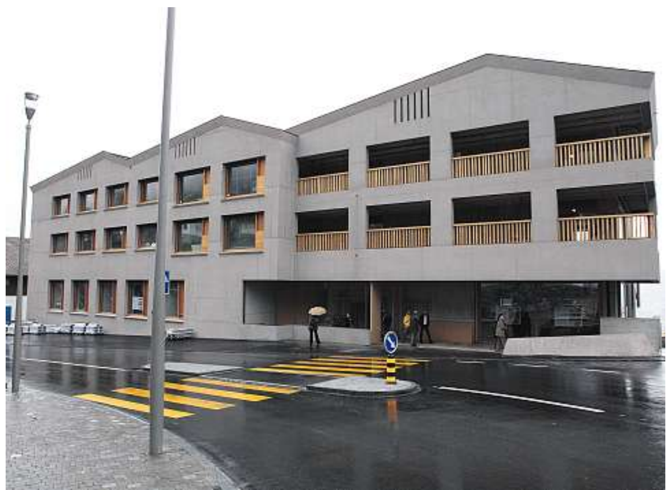
Einzugsbereit: Die ersten Bewohner beziehen nächste Woche ihre Zimmer im Haus «St. Theodul» in Triesenberg. Das Pflegewohnheim befindet sich mitten im Dorf, was den Bewohnern ermöglicht, am Dorfleben teilzunehmen. Bild Archiv Elma Korac
